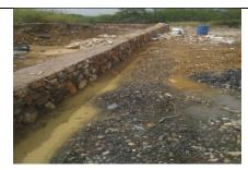
RETAINING WALL AROUND WASTE DUMP
