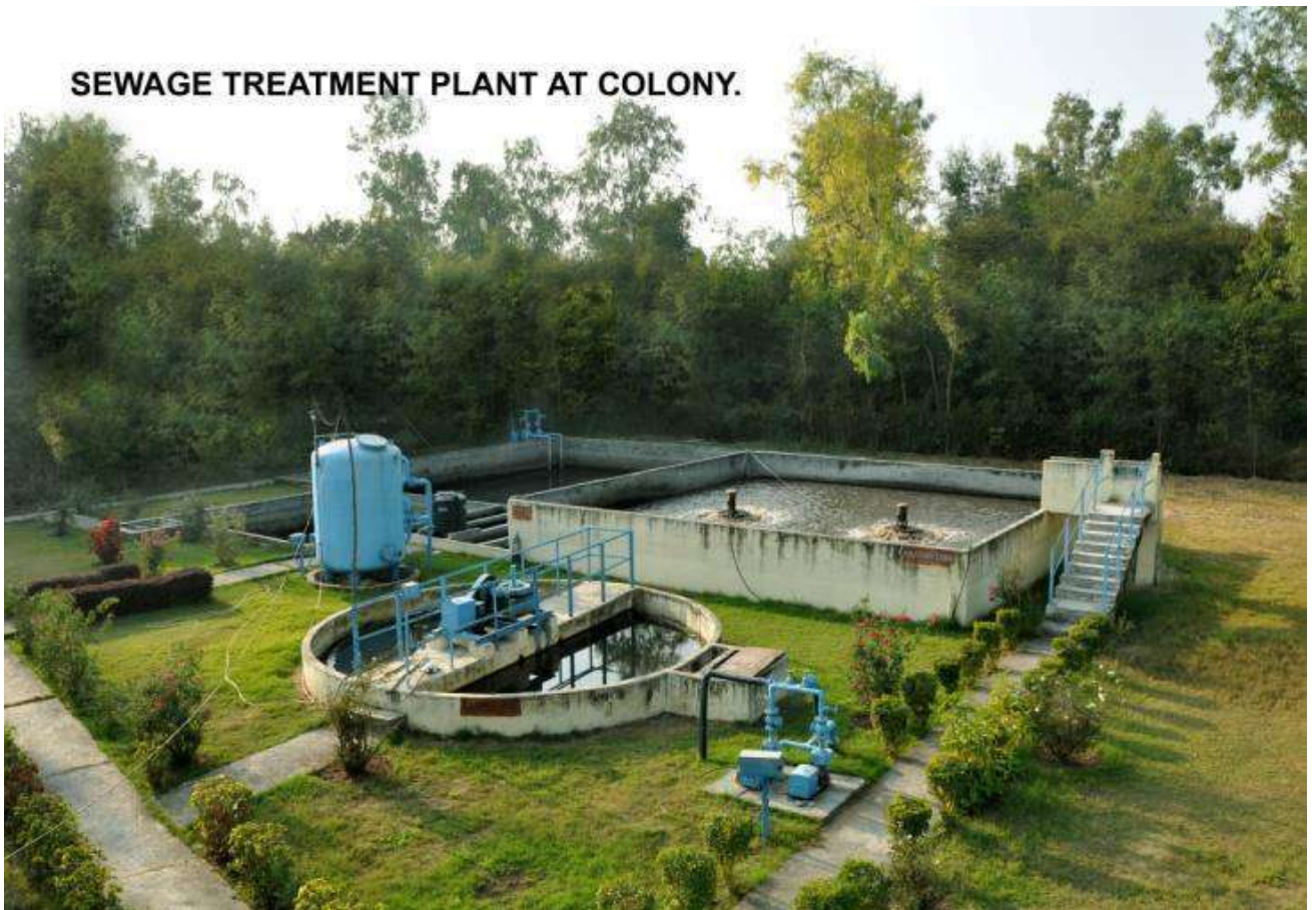
STP (300KLD & 425 KLD)
